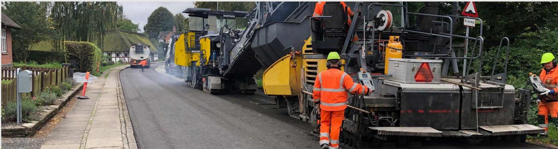
På Rødamsvej i Ryslinge by tester Arkil BSM fræsemetoden, som udmærker sig ved at 100% genbrug af den gamle asfalt og med mindst 90% reduktion i CO2 udledning.
