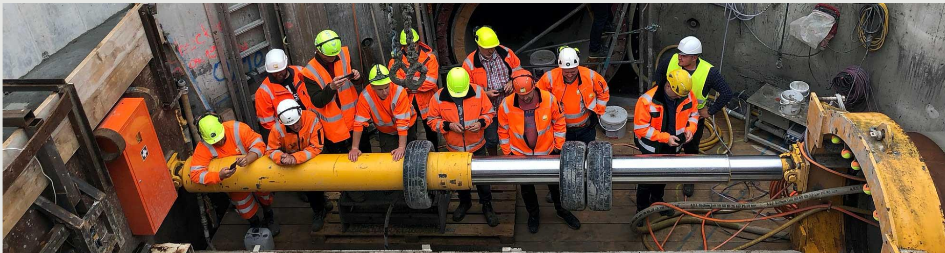
På netværkstur besøgte formandsaspiranterne Damhusledningen i Hvidovre for at se tunnelmaskinen Gudruns ankomsten på tunnelstrækningen.
