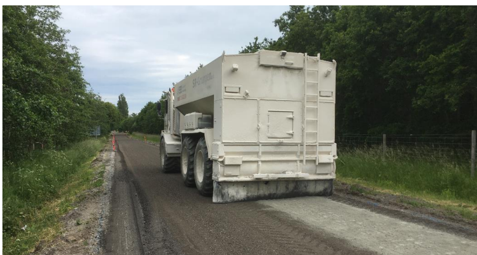
Fig. 4.1: Efter udspremdning af 10 cm tilført, knust genbrugsasfalt blev der udspremt cement, der virker som klæbeaktiv filler, når det indblandes i BSM-materialet.
