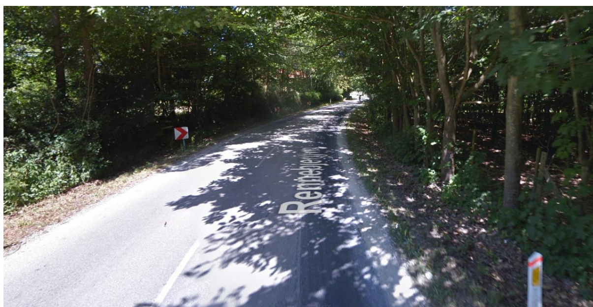
Fig. 3.4: En del af Rennebjergvej-strækningen løber gennem et skovareal (Foto: Google 2018)
