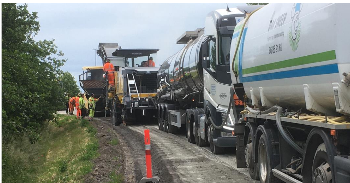
Fig. 4.2: Langt "tog" af maskiner/køretøjer i aktion ved BSM in-situ produktion og udlægning i én kontinuerlig arbejdsproces. BSM-stabiliseringen blev udført i en halv vejbredde ad gangen.
