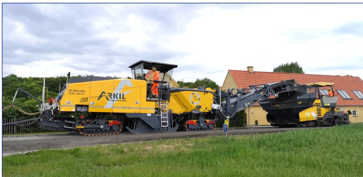
Fig. 4.4: CRI-maskinen i aktion på Rennebjergvej efterfulgt af asfaltudlæggeren.
