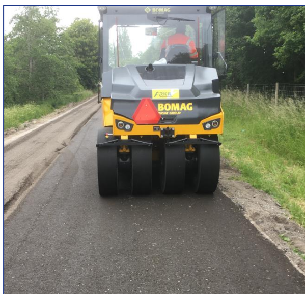
Fig. 4.6: Afsluttende komprimering med gummihjulstromle
