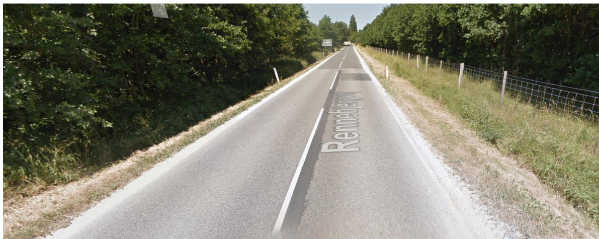
Fig. 3.3: Rennebjergvejs sydligste del før renoveringsarbejdet (set mod nord) – omfattende lapper og kantforstærkninger (Foto: Google, 2018)
