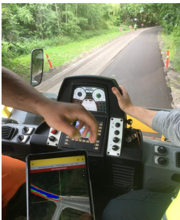
Fig. 4.8: Komprimeringsens ensartethed blev sikret ved hjælp af et GPS-baseret system og oversigt på en iPad.
