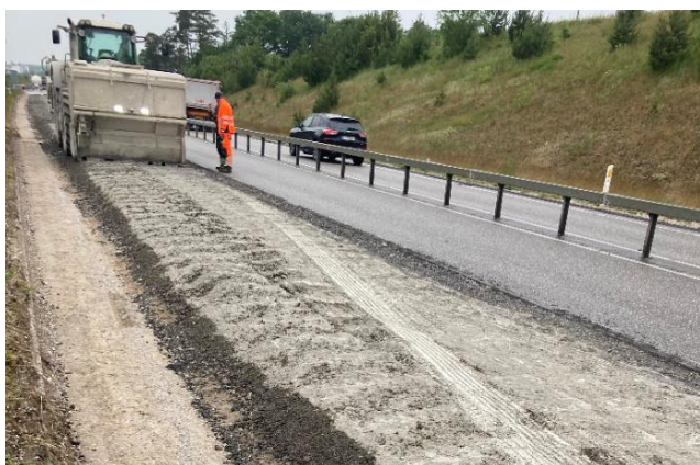
Fig. 2.3: Udspredning af flyveaske og cement ovenpå den udsprede genbrugsasfalt forud for BSM-fremstilling og udlægning.
