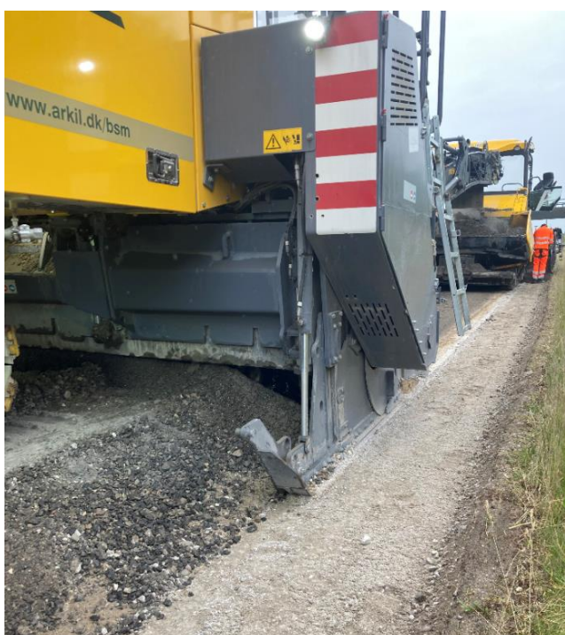
Fig. 2.5: Nærbillede af CRI-maskinens opsamling af udsprede genbrugsasfalt, flyveaske og cement. Bagved kører en traditionel asfaltudlægger med højkomprimeringsstrygejern samt glatvalset vibrationstromle og gummihjulstromle.
