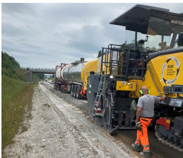
Fig. 2.4: BSM-insitu "toget" i aktion: Vandvogn, bitumentankvogn og Wirtgen CRI-fræse-/ blandemaskine.
